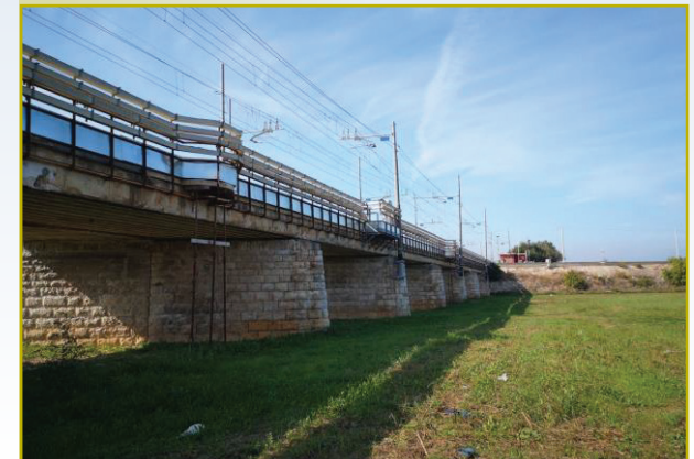
Ponte ferroviario in muratura, località Lamasinata, Bari
