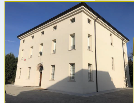
Sistema di monitoraggio installato presso Corte Margonara
