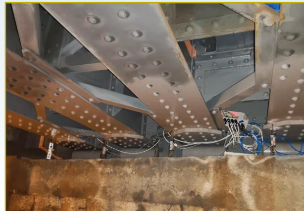
Ponte metallico in via Bruno Buozzi, Bari
