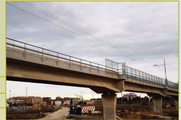
Ponte su selle Gerber monitorato a San Benedetto Po (Mantova)
